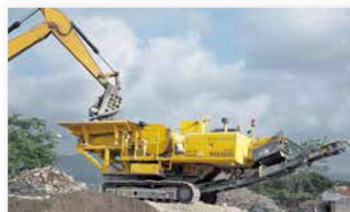
破碎作業写真
